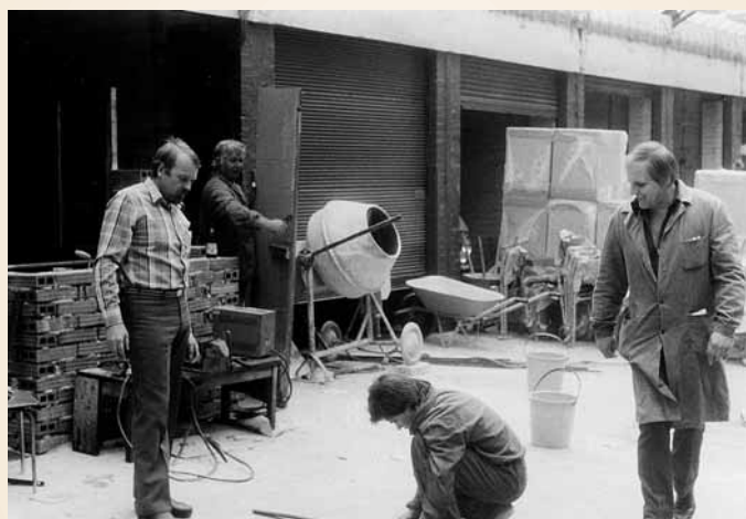
Budování stanoviště na Žižkově
