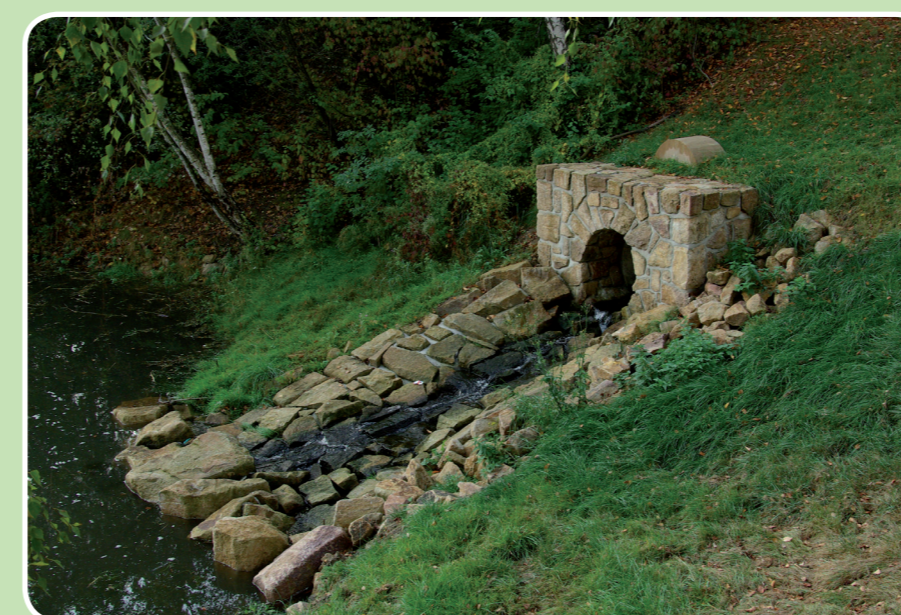
Příklad upravené výusti se skluzem
