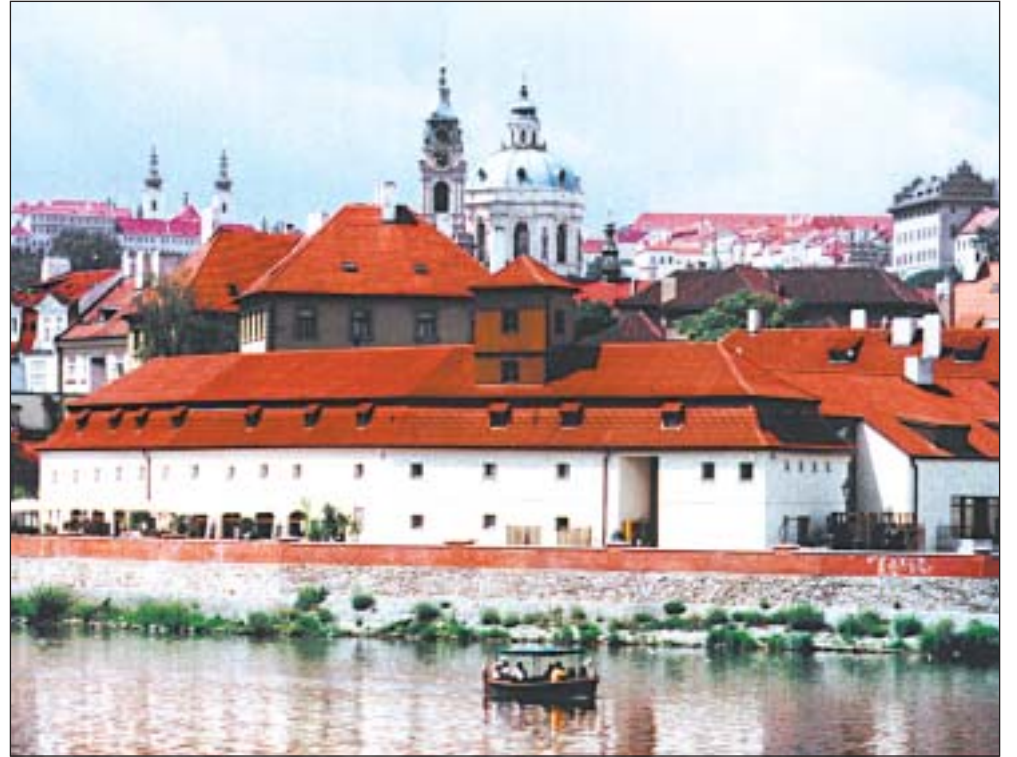
U Hergetovy cihelny je již stavba protipovodňové hráže dokončena.
