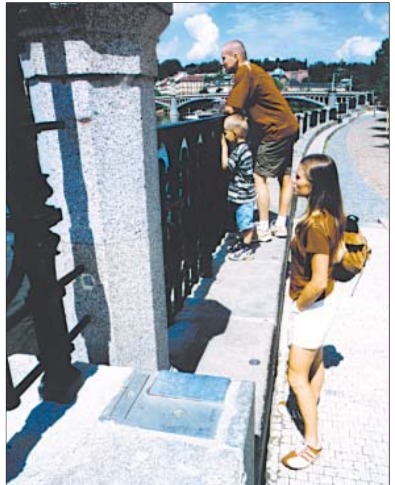
Na březích Vltavy se objeví mnohem více těchto patič pro instalaci mobilních protipovodňových zábran. Foto: Jaroslav Jiříčka
