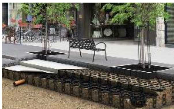
Obrázek 13: Příklad prokořenitelného boxu - systém Strata Cell. ( www.greenblue.com )
