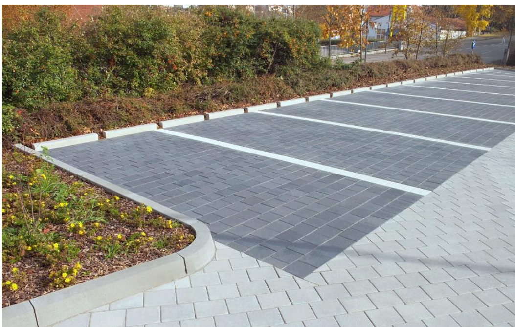
Obrázek 11. Příklad propustných povrchů - mezerovitý pórobeton.
