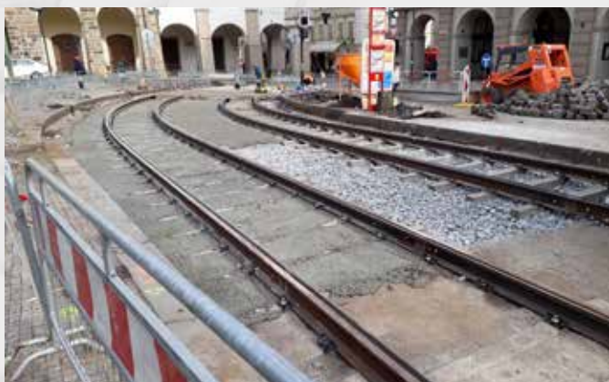
Zalžití pražců výplňovým betonem | Laying of sleepers into the compacted gravel bed
